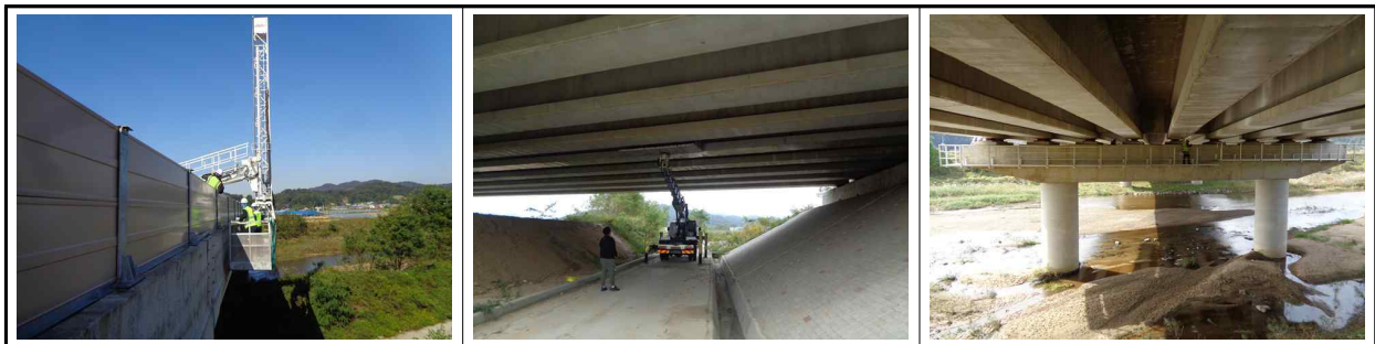
[고소작업차, 굴절점검차를 이용한 근접조사 실시]
