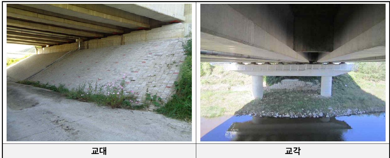
[교대 및 교각 전경]
